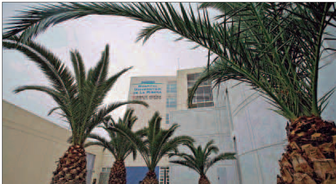
Vista general del Hospital de La Ribera.
